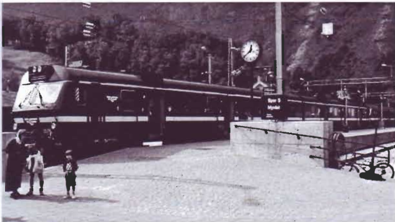
. . . und später: mit viel Beton und Stein, einer S-Bahn-Station ähnlich, mit neuen Wagen, gefragt bei Gästen aus aller Welt.
