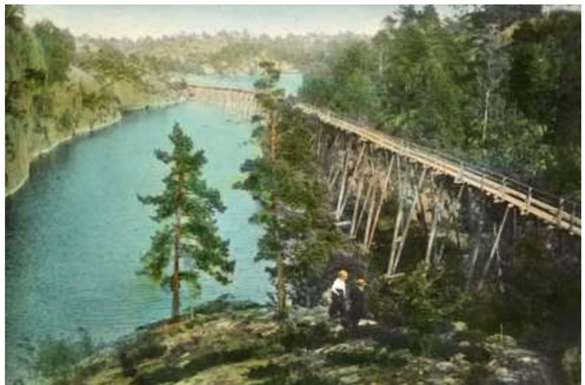
*Die für den Transport der Eisblöcke errichtete Gleitbahn bei Stabbestad, Kragerø. Die Länge der Gleitbahn zeigt eindrucksvoll die teils aufwändige Infrastruktur, die für den Transport des Eises von den zur Eisproduktion genutzten Gewässern zu den Verladestellen unmittelbar am Fjord angelegt wurde (ca. 1900). Foto: John Lyng-Olsen, Lyng Olsen Sammlung im Berg-Kragerø Museum, Kragerø*
