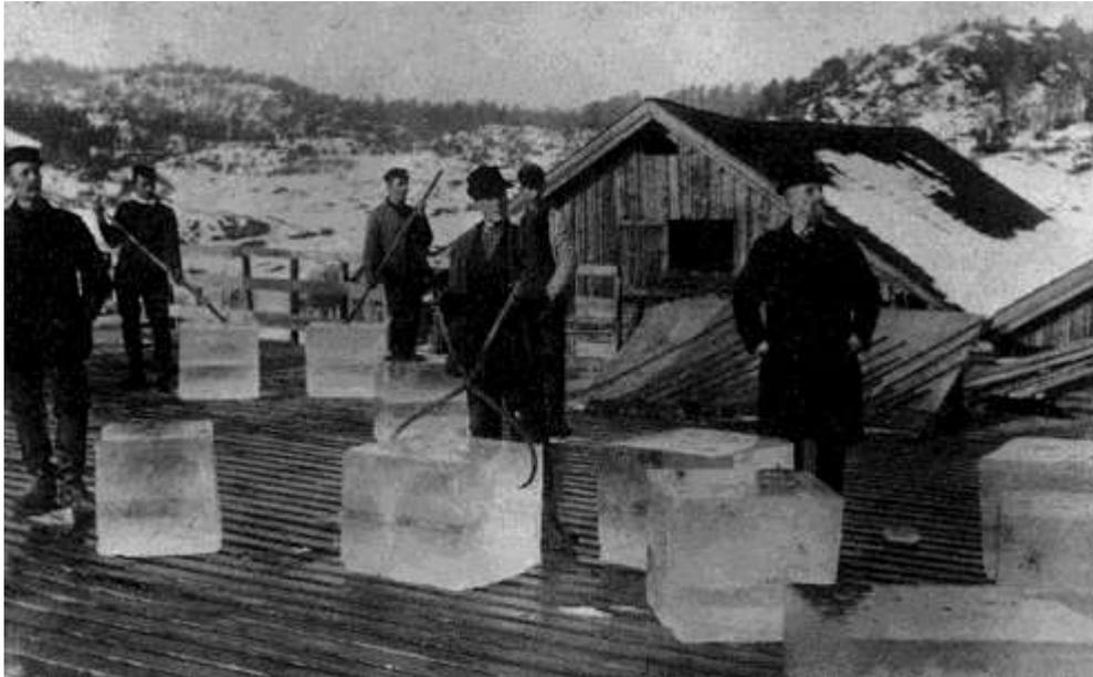
*Eisblöcke vor der Verladung in der Nähe von Kragerø (ca. 1900). Der Transport der Blöcke erfolgte mittels eines ausgeklügelten Systems von Gleitbahnen, so dass ein manuelles Heben der Blöcke weitgehend vermieden wurde. Dennoch gab es spezialisierte Greifzangen und Eishaken, die sowohl für den Transport an Land wie auch zum Stauen an Bord der Schiffe genutzt wurden. (Sammlung des Berg-Kragerø Museum, Kragerø)*
